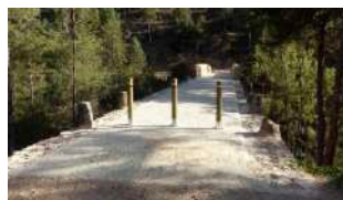
El Chantre Bridge
