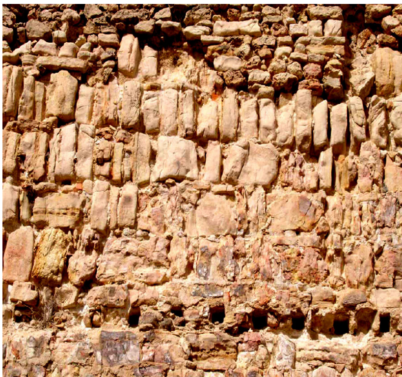
FIG.3.- FÁBRICA DE SILLARES APICONADOS DISPUESTOS EN VERTICAL DEL TORREÓN ORIGINAL ISLÁMICO DEL CASTILLO. (FOTO: MÍCHEL MUÑOZ.)
