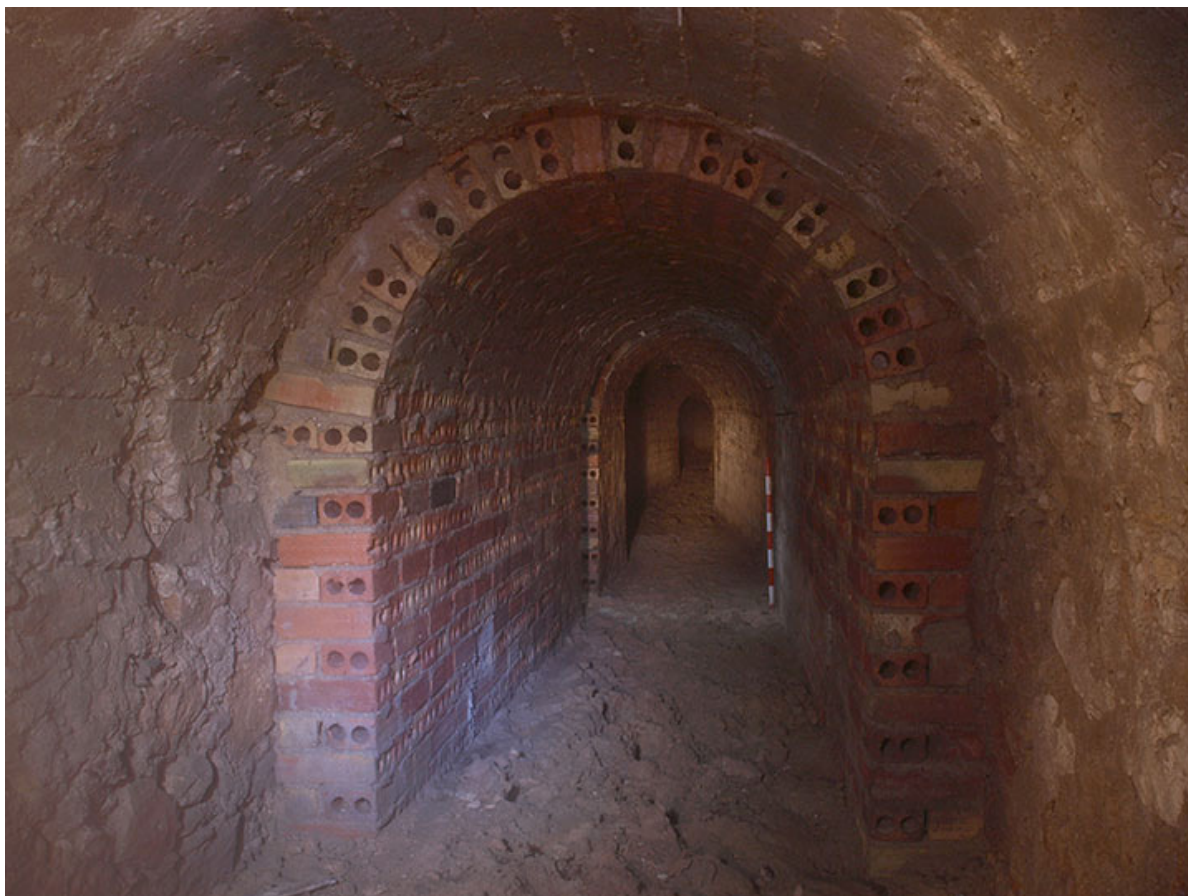
FIG. 11.- REFUGIO ANTIAÉREO DEL CERRILLO DE SAN ROQUE. (FOTO: SANTIAGO D. DOMÍNGUEZ-SOLERA.)
