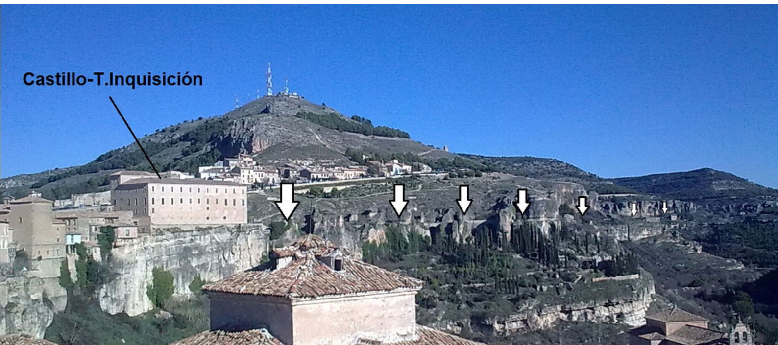
FIG. 12.- ACUEDUCTO DE CUENCA EN LA HOZ DEL HUÉCAR. (FOTO: SANTIAGO D. DOMÍNGUEZ-SOLERA.)
